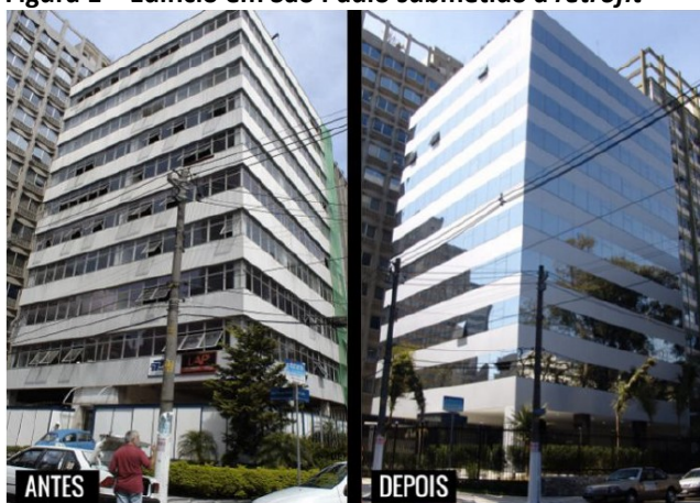
Figura 1 – Edifício em São Paulo submetido a retrofit
