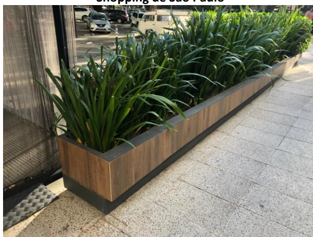
Figura 5 – Floreira de acabamento cerâmico e proteção nas quinas instaladas nas áreas externas de um Shopping de São Paulo
