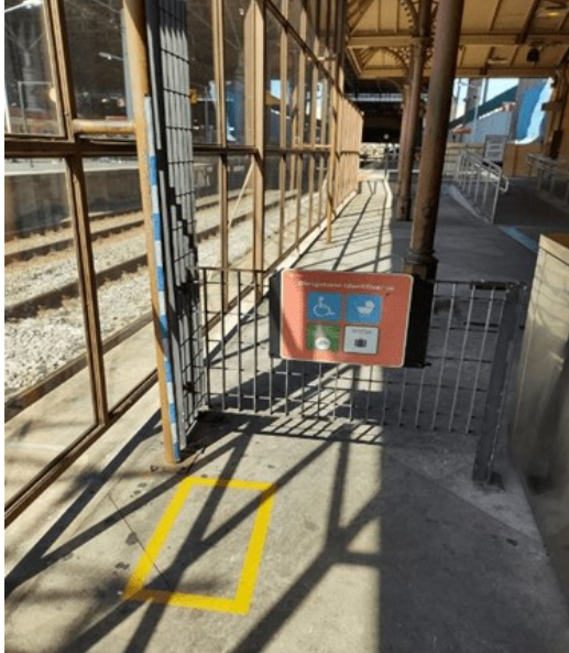
Figura 6 – Gabarito limitador na linha de bloqueios da plataforma 1
